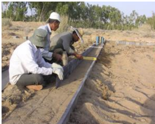
شکل ۲- مراحل نصب پارشال فلوم و فلوم
