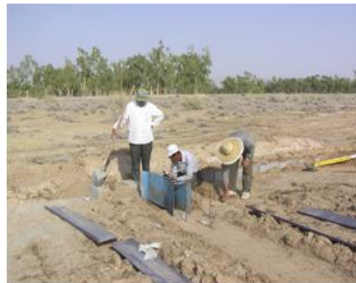
شکل ۲- مراحل نصب پارشال فلوم و فلوم
