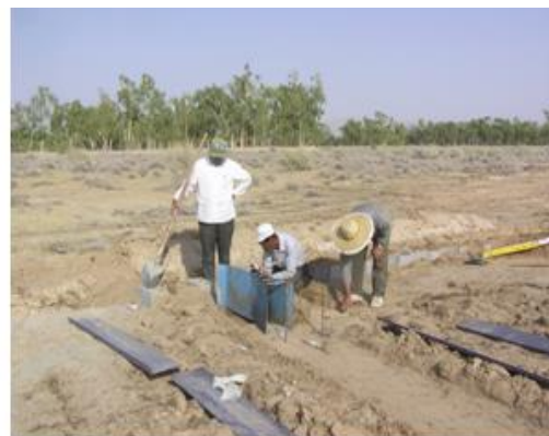
شکل ۲- مراحل نصب پارشال فلوم و فلوم
