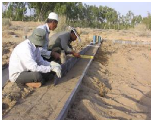
شکل ۲- مراحل نصب پارشال فلوم و فلوم
